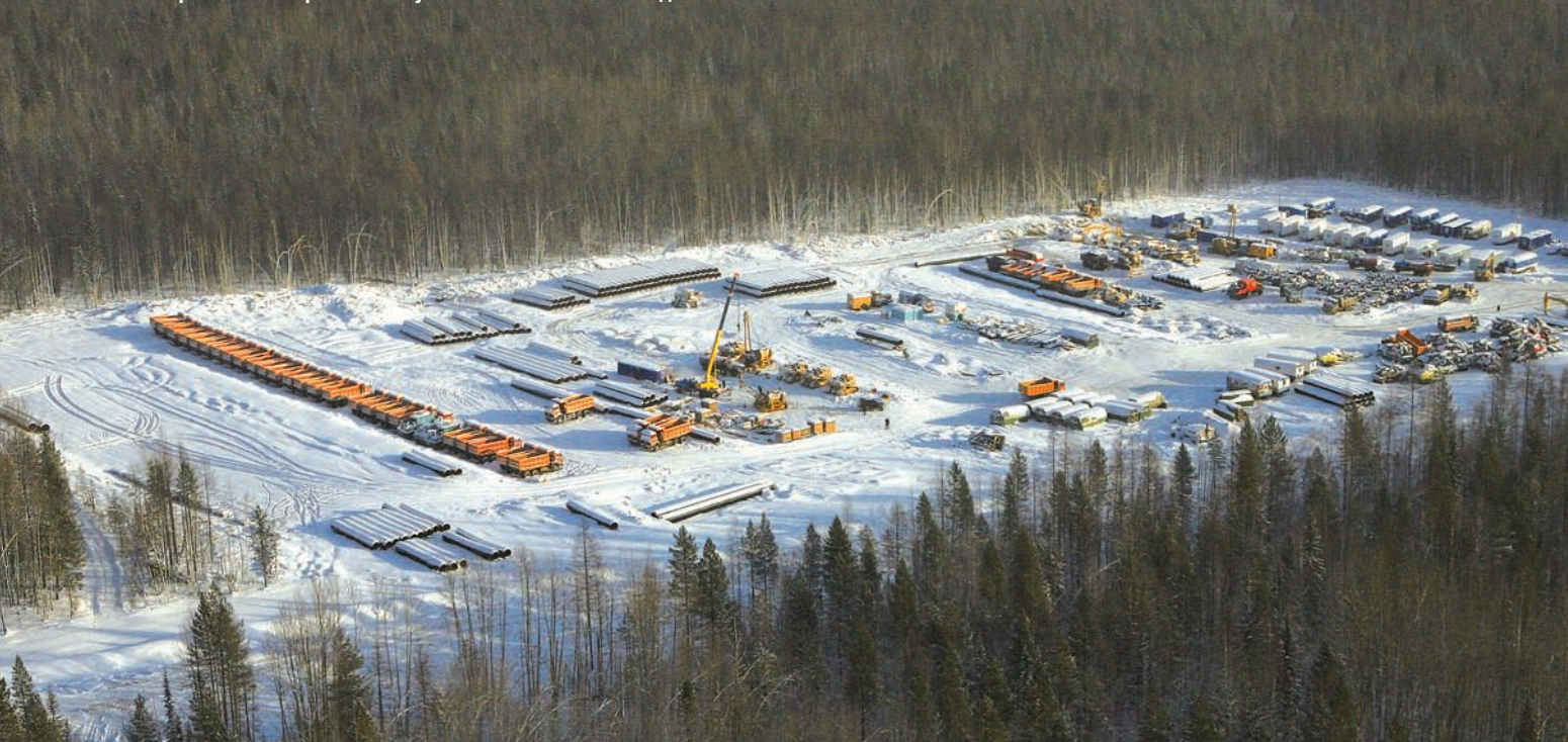
Строительные работы на участке Олекминск – Алдан
